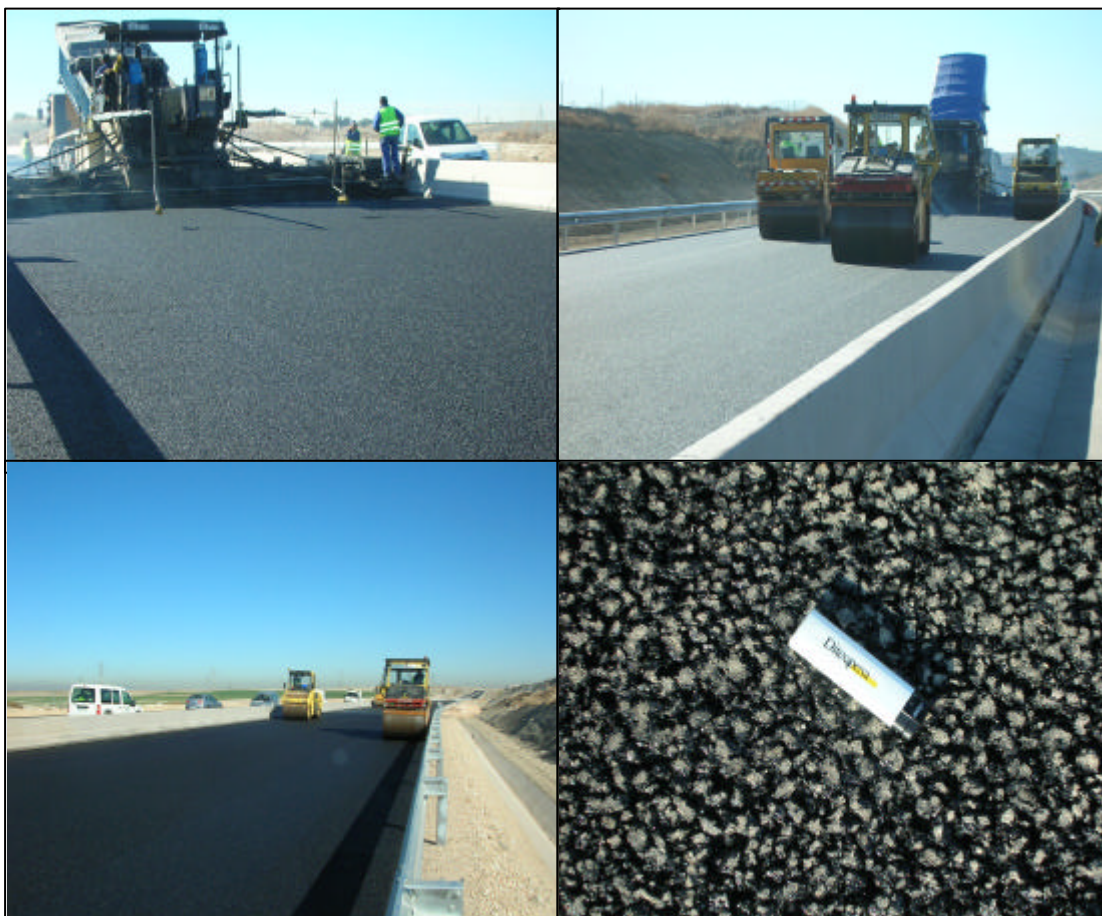
Fotografías ejecución de la obra y detalle de la textura superficial.
