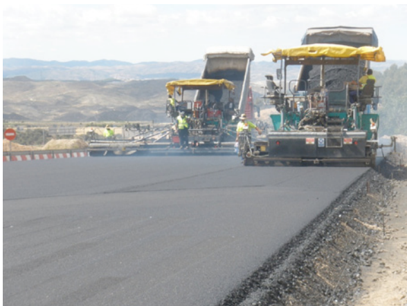
Extendido de una mezcla asfáltica en obra.
